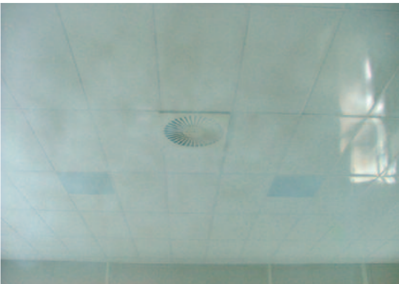
Slika 6 Istrujavanje iz stropnog difuzora uz prisutnost "Coanda efekta"
