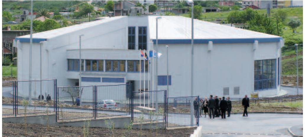
Slika 2. Crpna stanica Ravne Njive za vodoopskrbu grada Splita
